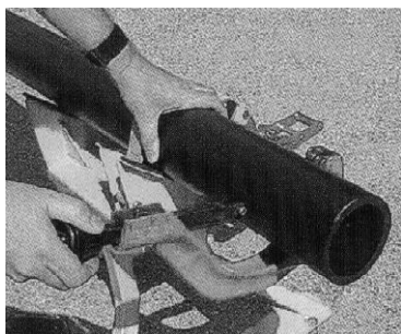
Taierea capetelor de conducta la unghi de 90 de grade.
