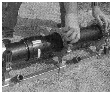
Fixarea elementelor de sudat in aliniator
